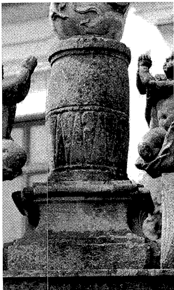
Obr. č. 25: Profilovaná patka a dřík sloupu sochy Panny Marie. Znečištění povrchu, boiologické napadení, různorodé starší dožívající tmely s nevhodnou barevností a strukturou.
