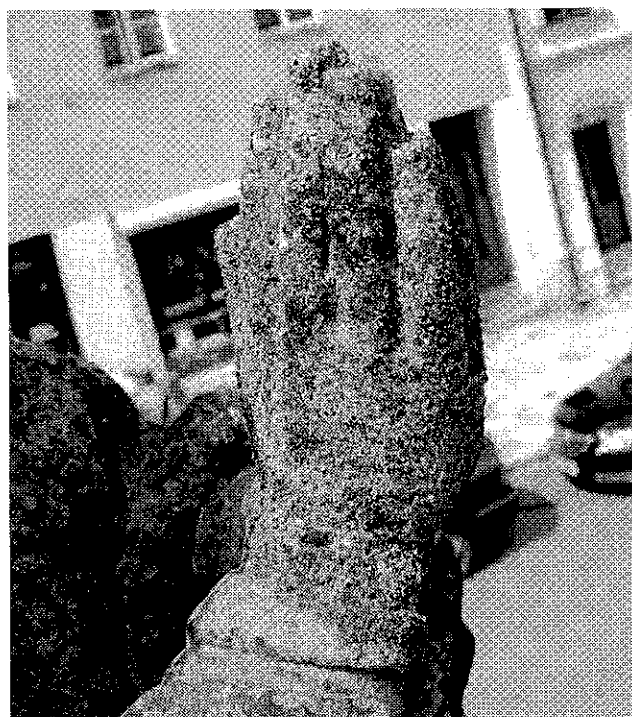
Obr. č. 31-32: Ruce sochy Panny Mari. Sepjaté ruce jsou zhotoveny z umělého kamene. Ten je již dožilý, drolí se a je povrchově zvětralý vlivem biologického napadení a větrné abraze.
