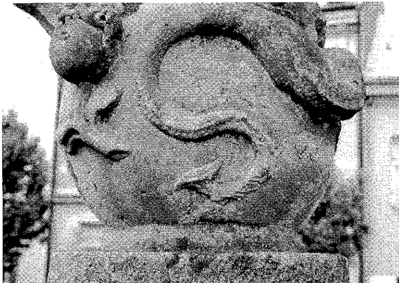
Obr. č. 27: Čelní strana zemského glóbu ovinutého hadem na kterém stojí socha Panny Marie. Viditelná zatmelená prasklina spodní poloviny glóbu.
