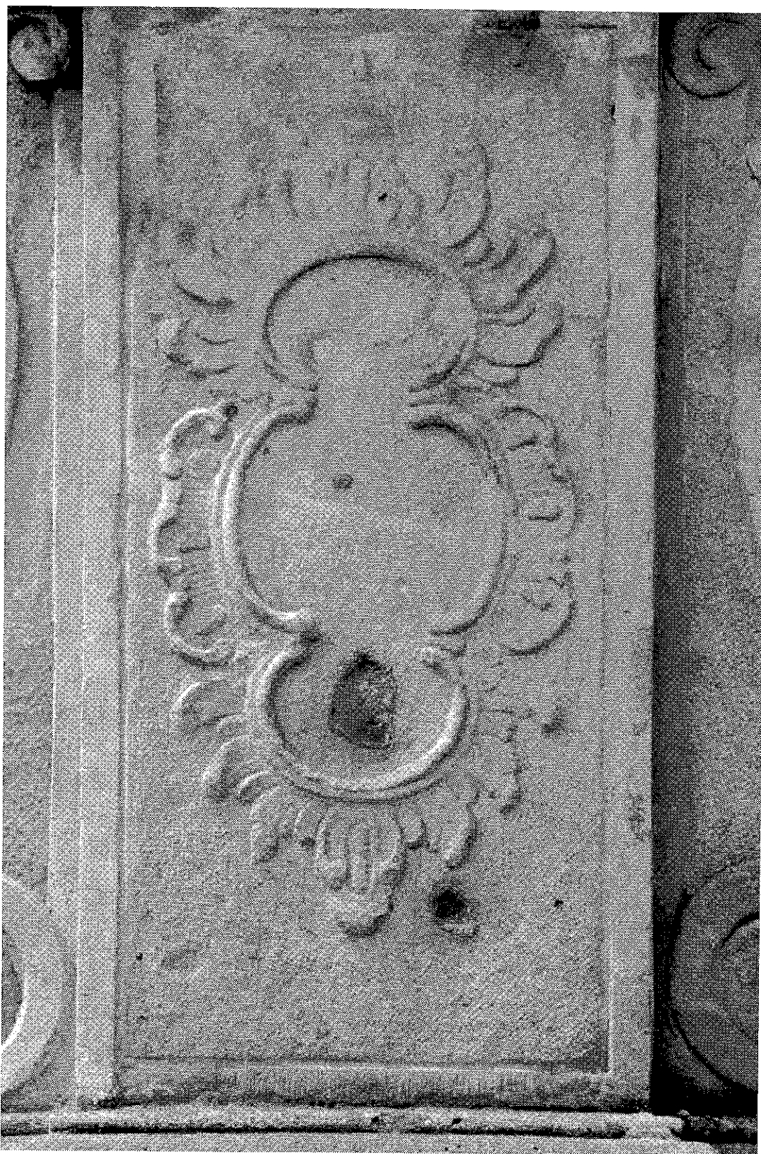
Obr. č. 10: Čelní strana středního bloku podstavce. Zvětrání kamene, korozní jádra pyritových ložisek, různorodé starší dožívající tmely s nevhodnou barevností a strukturou.
