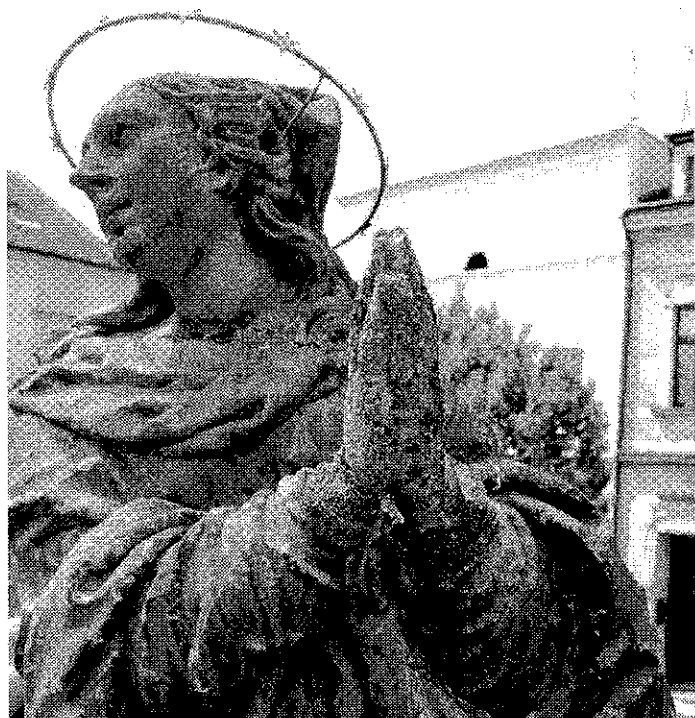
Obr. č. 31-32: Ruce sochy Panny Mari. Sepjaté ruce jsou zhotoveny z umělého kamene. Ten je již dožilý, drolí se a je povrchově zvětralý vlivem biologického napadení a větrné abraze.
