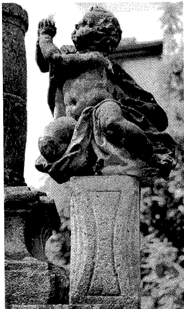
Obr. č. 17: Andílek na sloupku po levé straně sochy Panny Marie, v deštových stínech jsou vidět silné tmavé sádrovcové krusty.
