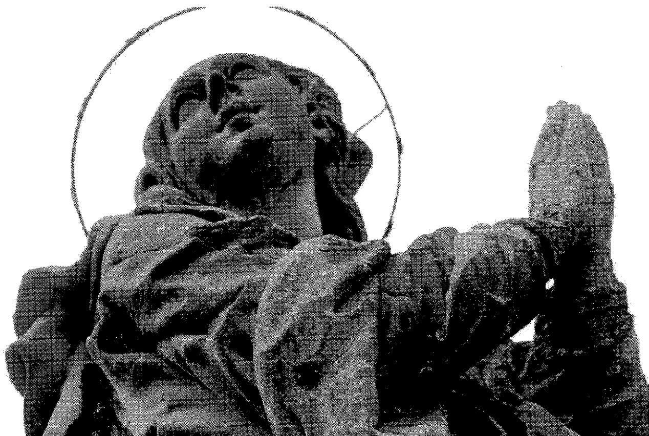
Obr. č. 31: Spodní pohled na hlavu sochy Panny Marie se svatozáří. Viditelná vodorovná hluboká prasklina v místě předloktí až po rameno. Biologické napadení kamene, nečistoty, důlková degradace.
