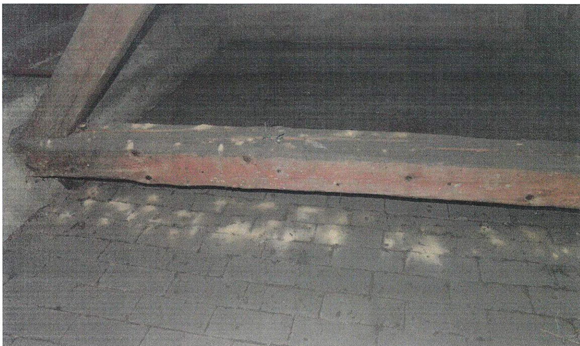
Napadený vazný trám (na podlaze stopy činnosti dřevokazného hmyzu)
